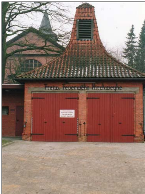
Gerätehausvorplatz ist gepflastert worden
