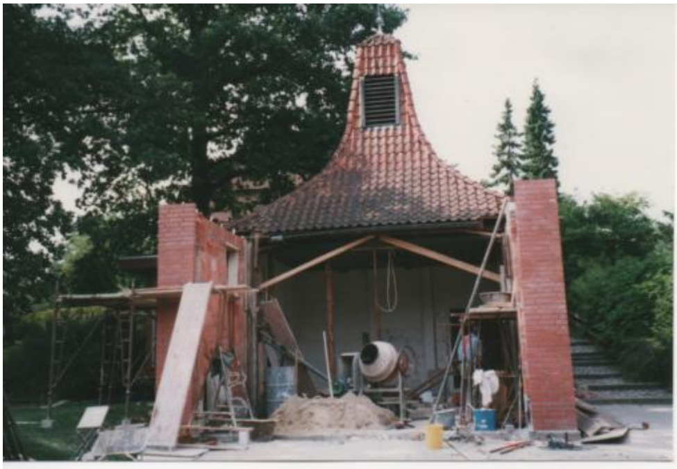
Der Rohbau unserer neuen Fahrzeughalle
