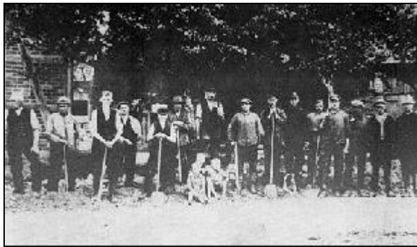
Bau der Wasserleitung 1926
